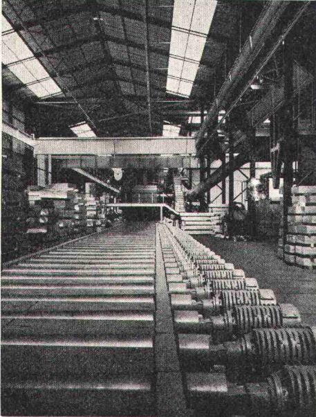
Einlaufrollgang des Grobwalzwerkes in Aluminium-Verarbeitungsbetrieb. — Wartungsfreie Stirnrad-Fussgetriebe, zusammengebaut mit Gleichstrommotoren.
