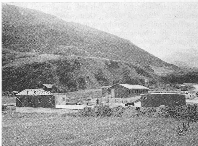
Erstellen von Werk- und Unterbaracken am südlichen Dorfausgang von Realp unterhalb der ansteigenden Furkapass-Strasse. (Ria-Photo, Zürich)
