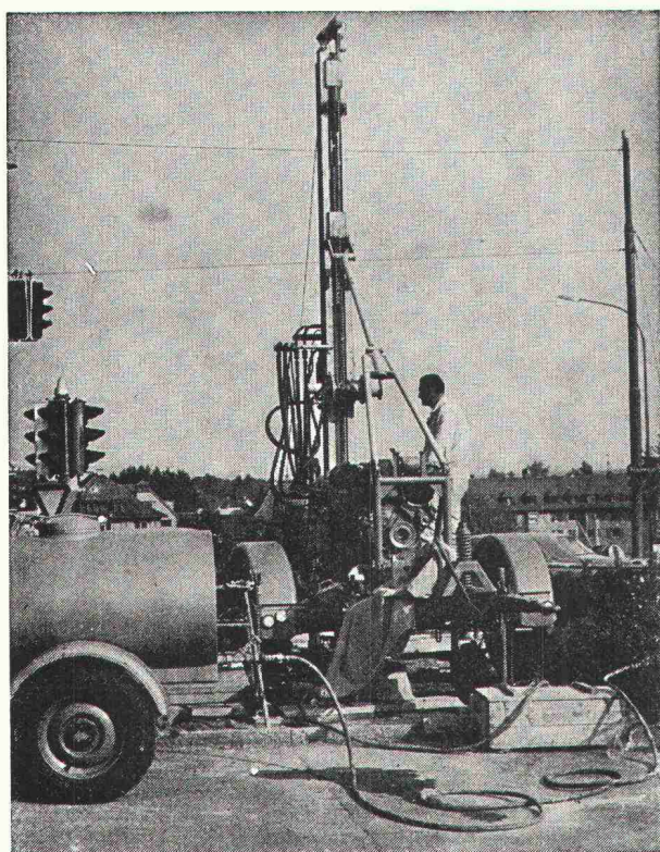
Sondierbohrung Bucheggplatz Zürich
