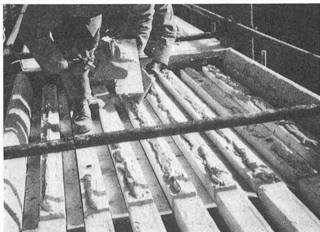
Bild 34. Aufbringen des Epoxyharz-Mörtels zum Kleben des Deckels auf das Zugbandelement. Sichtbar sind drei der vier Hülsen mit Innen-gewinde, welche den Deckel mittels vier Bolzen festhalten
