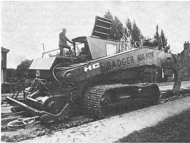
Bild 8. Automatische Rohrlegemaschine
