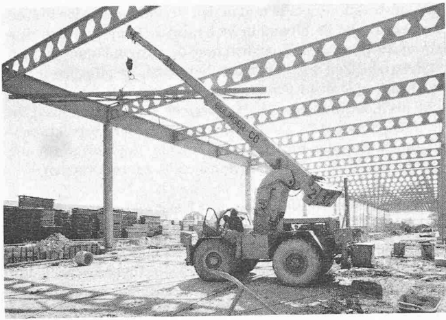
Bild 6. Zur Rationalisierung der Montage haben die modernen Auto-krane wesentlich beigetragen
