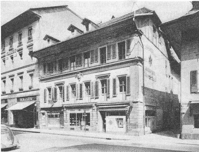
Das Tscharnerhaus an der Amtshausgasse in Bern, 1735
