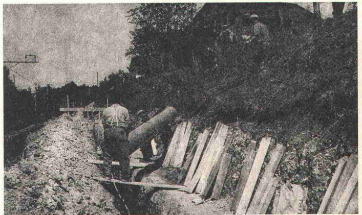
KALIDUR-Kanalisationsrohre, verlegt im Bahneinschnitt
