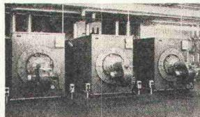
Die feuerungstechnischen Messungen an vielen Kesselanlagen ergaben überall einen Wirkungsgrad von über 90% und ruffreie Abgase. Die Heizzentrale des Ausbildungszentrums versorgt
