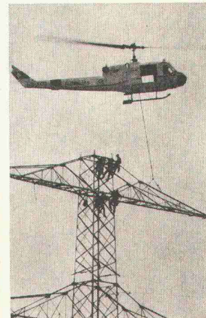
Aufstocken eines Oberteils
