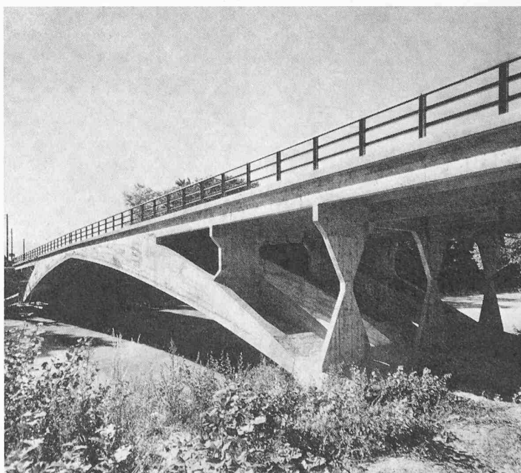
Arvebrücke bei Vessy (Genf), Spannweite 56 m. Erbaut 1936
