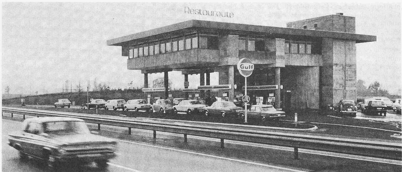
Die Tankstelle und Raststätte «Restauroute 3-Stern» Kölliken-Nord an der N1 Zürich—Bern. Die Anlage enthält im vertikalen Trakt vier Geschosse. Das die Tankstelle überkragende 4. Geschoss enthält den Restaurationsbetrieb (eine Cafeteria befindet sich im 1. Stock). Im Parkraum können 74 Wagen abgestellt werden.
