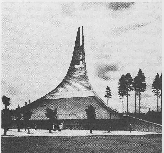
Bild 1. Evangelische Kirche in Lauritsala, Finnland. Das Dach weist über 180 m 2 Dreischeibenglas auf
