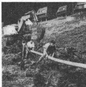
Kanalisation Schwyz: Rothenturm
