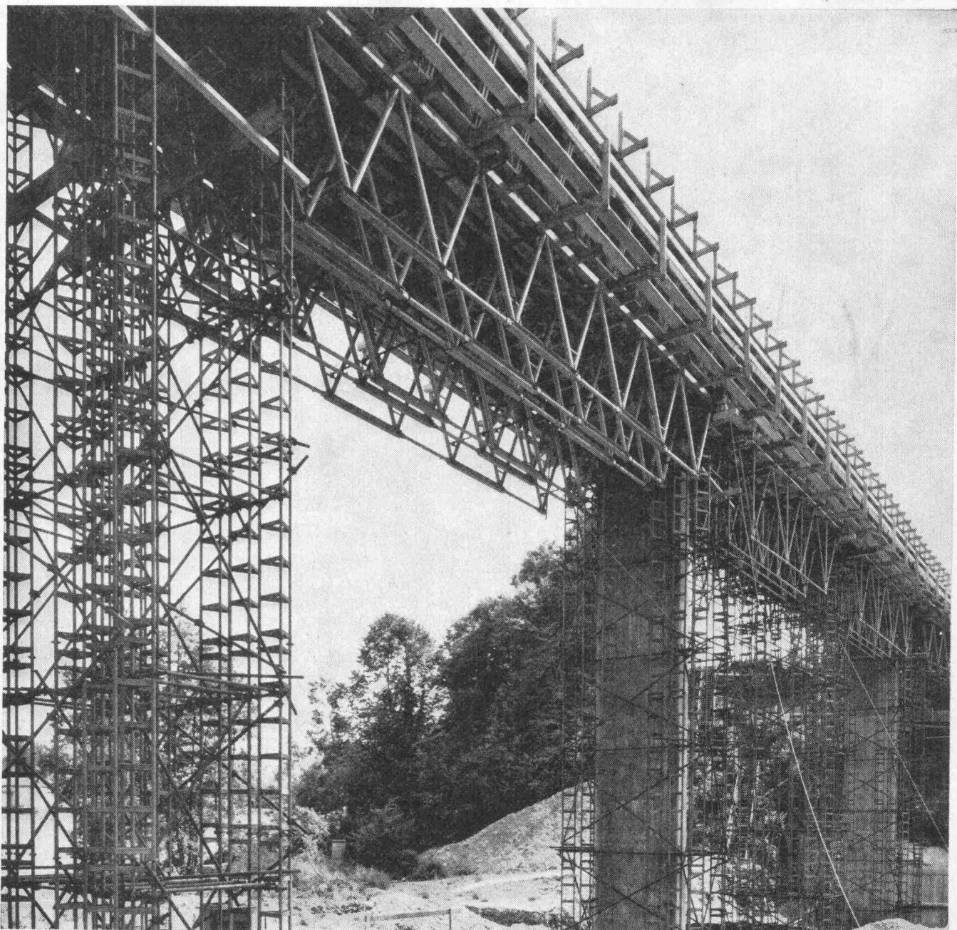
Kaistenbachbrücke bei Laufenburg AG, Länge 154 m
