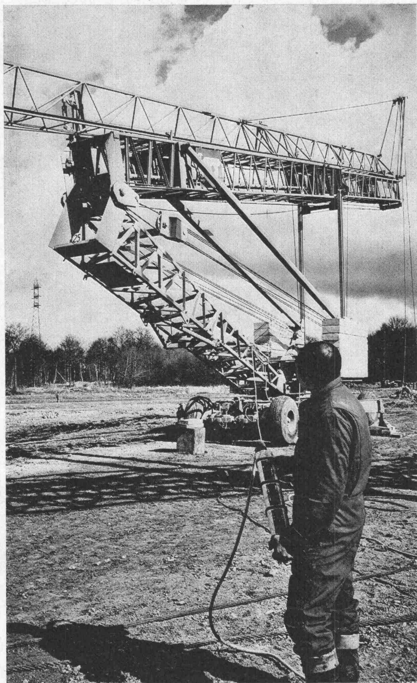
«Die Boilot-Krane sind innerhalb von 10 Minuten einsatzbereit»
