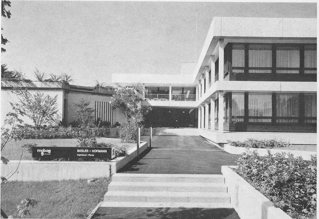
Ansicht von Süden mit Mensa-Anbau, Eingangspartie und Osttrakt an der Forchstrasse
