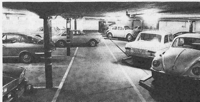
Bild 6. Befahren eines ortsfesten Parkplatzes. Die Plattformen haben sich vor diesem fächerförmig etwa 7 m weit geöffnet
