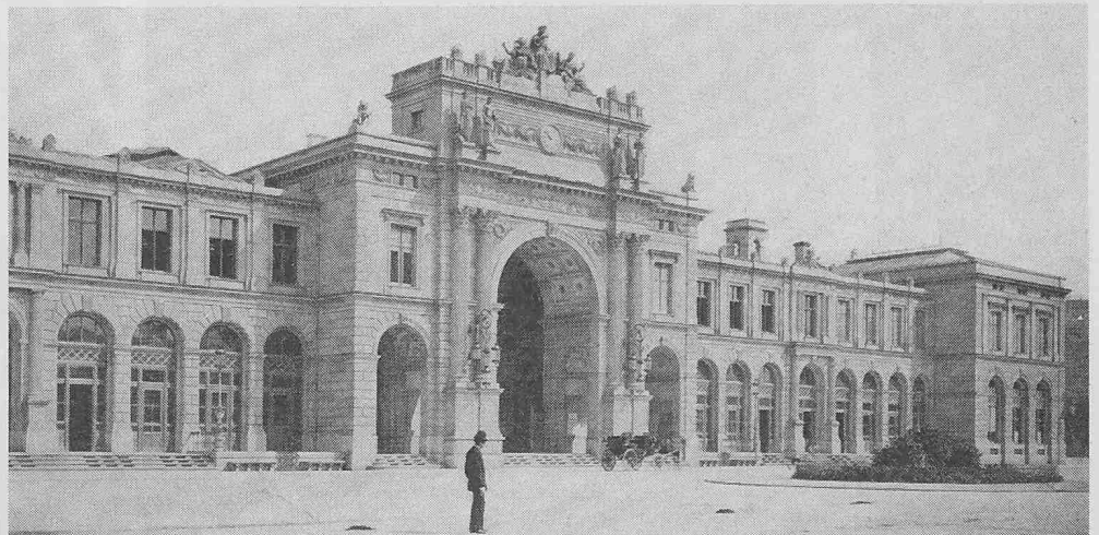
Bild 11. Die Fassade gegen den Bahnhofplatz vor 1889. Das Denkmal für Alfred Escher steht noch nicht. Der Bau leuchtet im noch hellen Sandstein. Die Stukkaturen im Portalbogen sind offenbar leicht getönt
