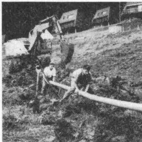
Kanalisation Schwyz: Rothenturm
