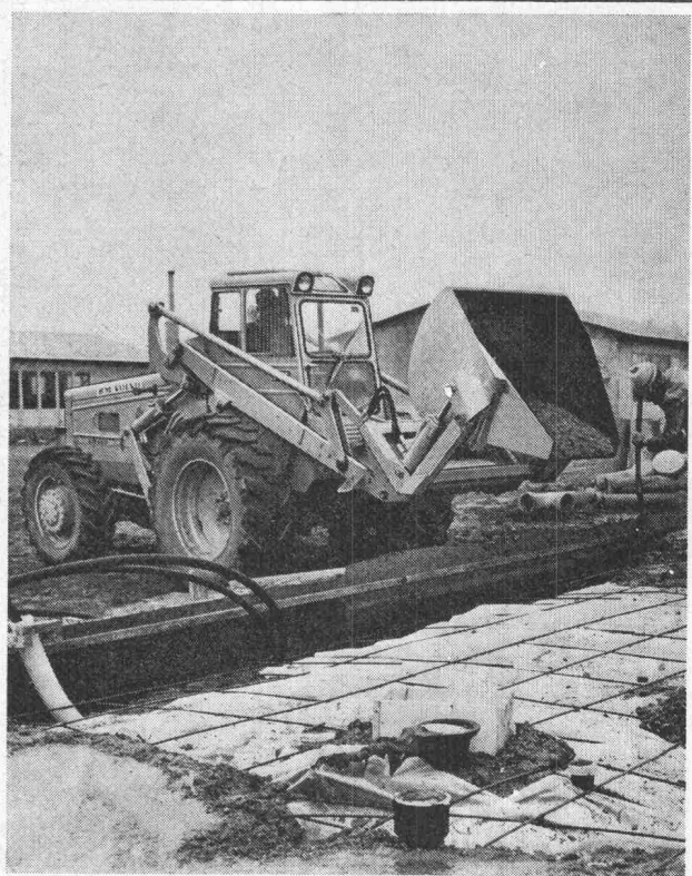
Er transportiert Fertigbeton und Kies.
