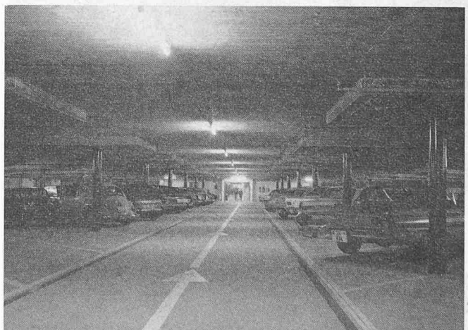
Bild 15. Beispiel von rationeller und bequemer 45^\circ -Parkierung im Parkhaus Hohe Promenade, Zürich
