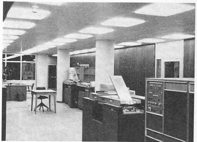
Bild 15. Computerraum mit «Unipro»-Montagedecke. Die Metallplatten sind mit Schnappverschlüssen an den Profilen der Unterkonstruktion befestigt
