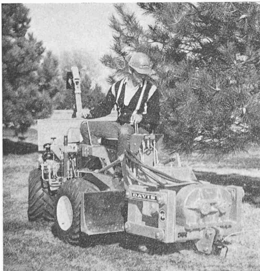
Bild 1. Kabelverlegegerät Typ Davis P 60 an Traktor angebaut
