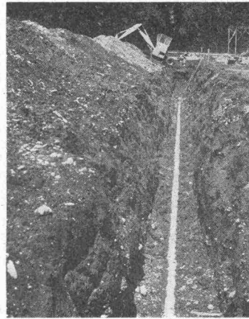
Graben für eine Rohrleitung
