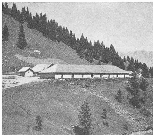
Bild 1. Querstall auf Alp Kohlschlag Untersäss, Gemeinde Mels, für 160 Grossvieheinheiten, erbaut 1893/94; Baukosten 13 000 Fr.
