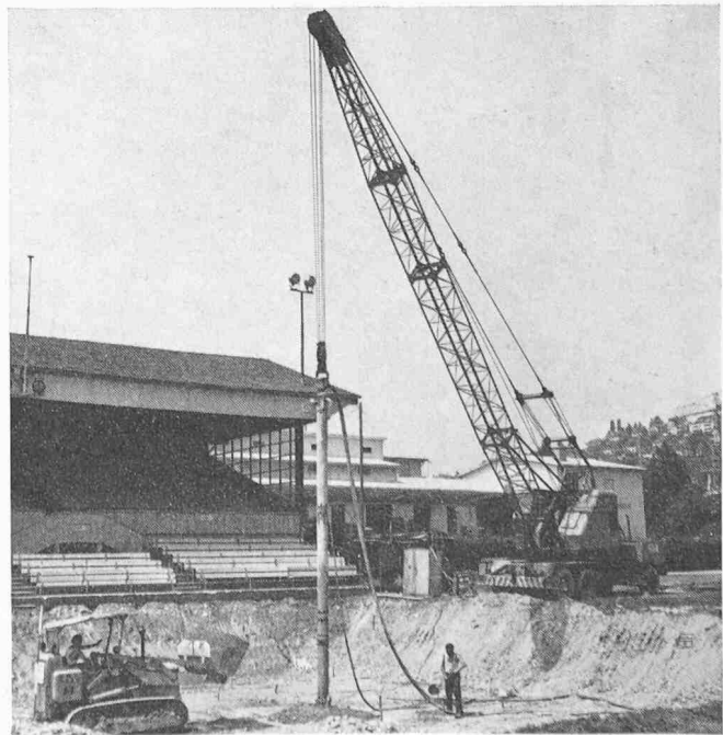
Bild 2. Torpedo-Rüttler mit Traggerät
