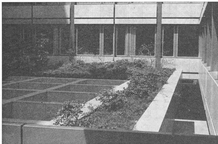
Rippenraster und Pflanzentröge (nördlich des Hauptzuganges Erweiterungsbau) bieten Luft- und Lichteinlass ins Parkgeschoss
