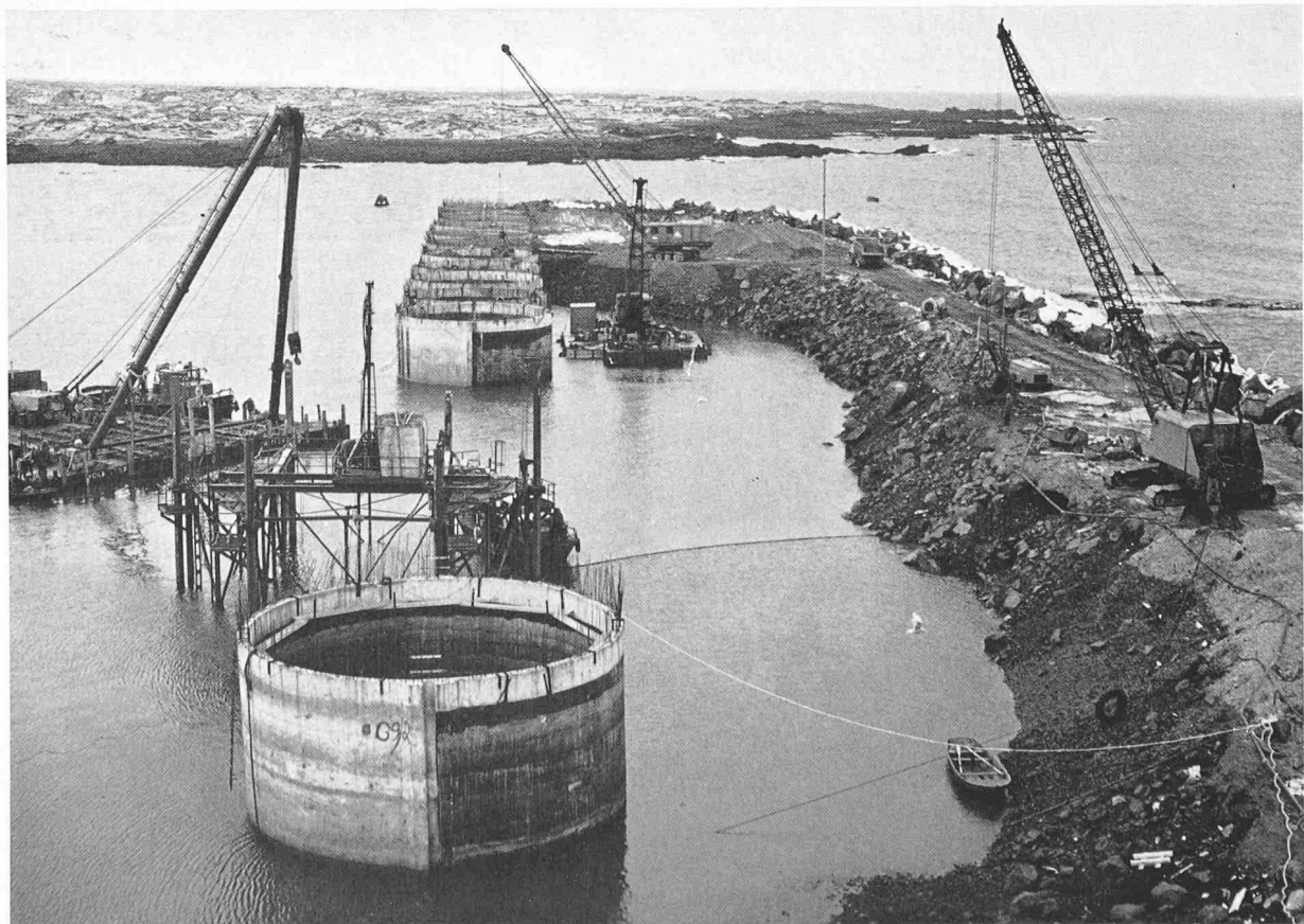
Bau der Hafenmole. Zustand vom 5. Februar 1969
