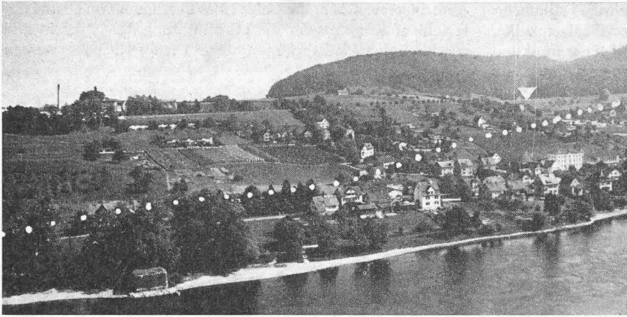
Bild 2. Flurlingen mit seinem infolge Projektierungssperre seit Jahren brachliegenden Erschliessungsgebiet. Vom Waldrand oben rechts bis zur bekannten Bindfadenfabrik (links oben) die heutige Zürcherstrasse (N 4). Die Zufahrt zu der von Schaffhausen geforderten Tiefbrücke – durch weisse Punkte angedeutet – würde diese aussichtsreiche Wohnzone in brutaler Weise von oben bis unten diagonal durchschneiden. Beim weissen Pfeil die Stelle, wo die im Text zur Diskussion gestellte Autobahnzufahrt von der N 4 abzweigen würde, um den Ausläufer des Kohlfirs in einem kurzen Tunnel zu durchstossen.
