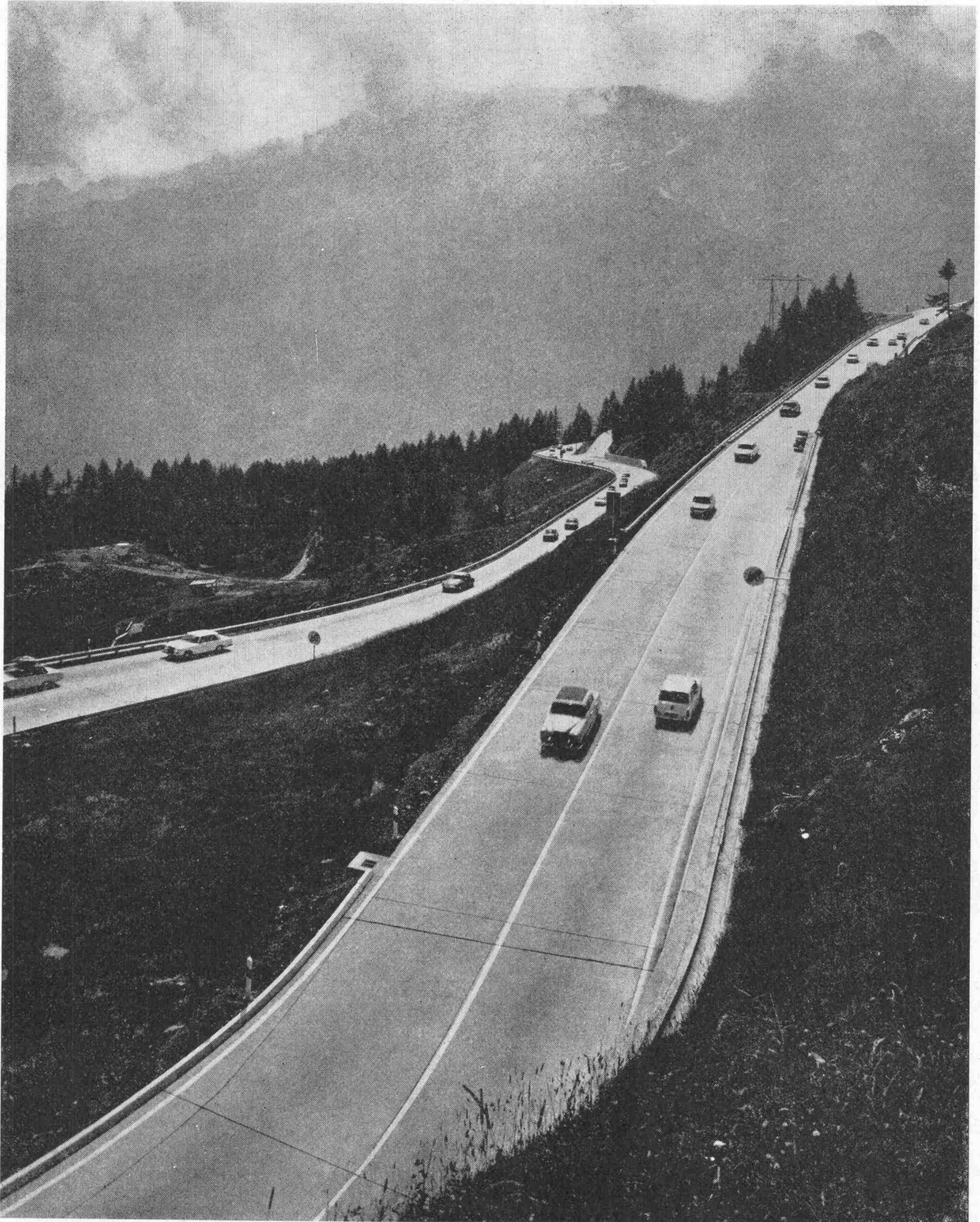
Nationalstrasse N2, Gotthard-Südrampe, Betonbelag
