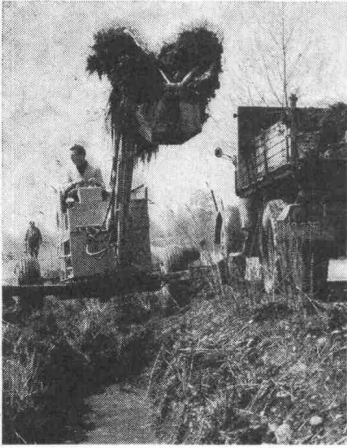
Arbeit mit dem Grabenlöffel
