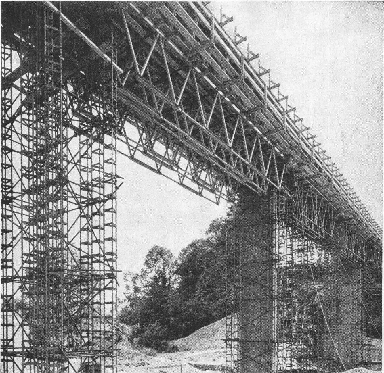
Kaistenbachbrücke bei Laufenburg AG, Länge 154 m
