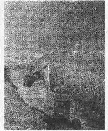
Arbeit in einem Bergbach
