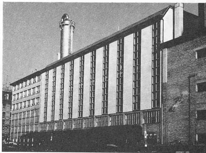
Bild 3. Ansicht von der Hardstrasse
