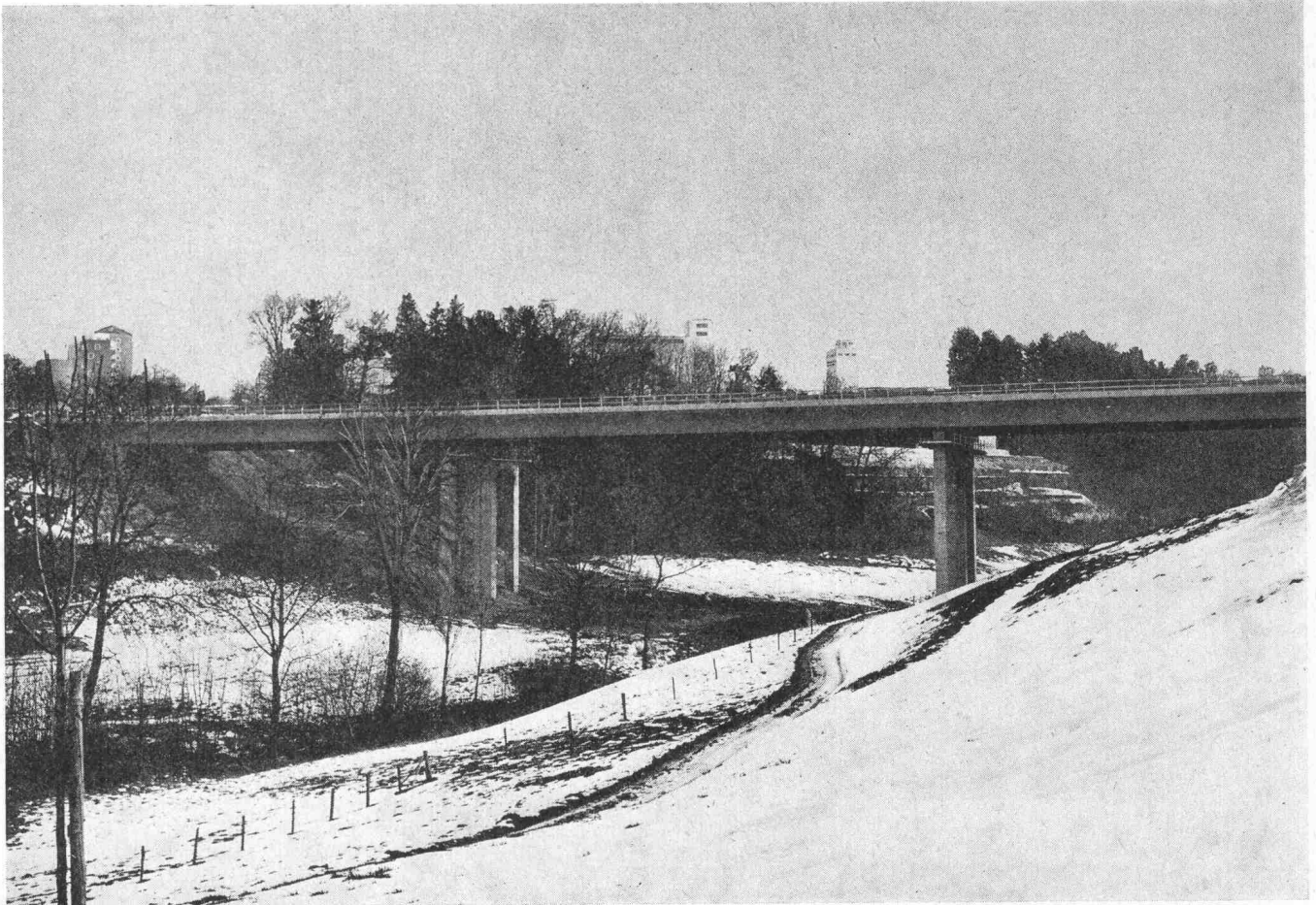
Viaduc de Guin, autoroute Berne—Vevey
