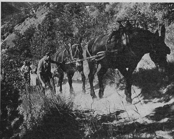
Bild 1. Transport von Stützen auf die Riederalp mit einem Maultiergespann im Jahre 1951 (Photo H. Heiniger, Spiez)
