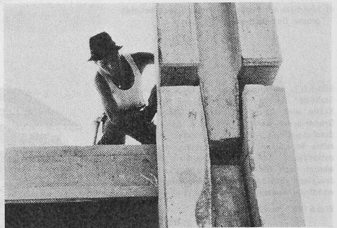
Montage einer Stütze
