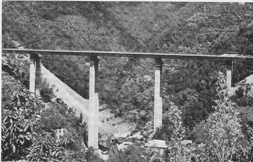
Bild 11. Die fertig eingeschobene Autobahnbrücke in Zoagli an der Autobahn Rapallo—Sestri-Levante
