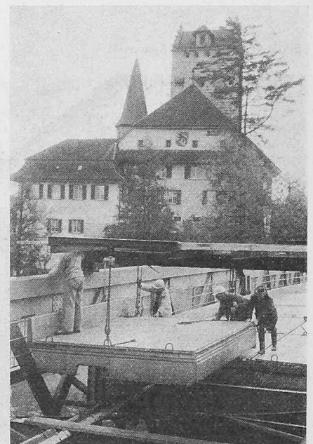
Bild 2. Versetzen der Fahrbahnelemente
