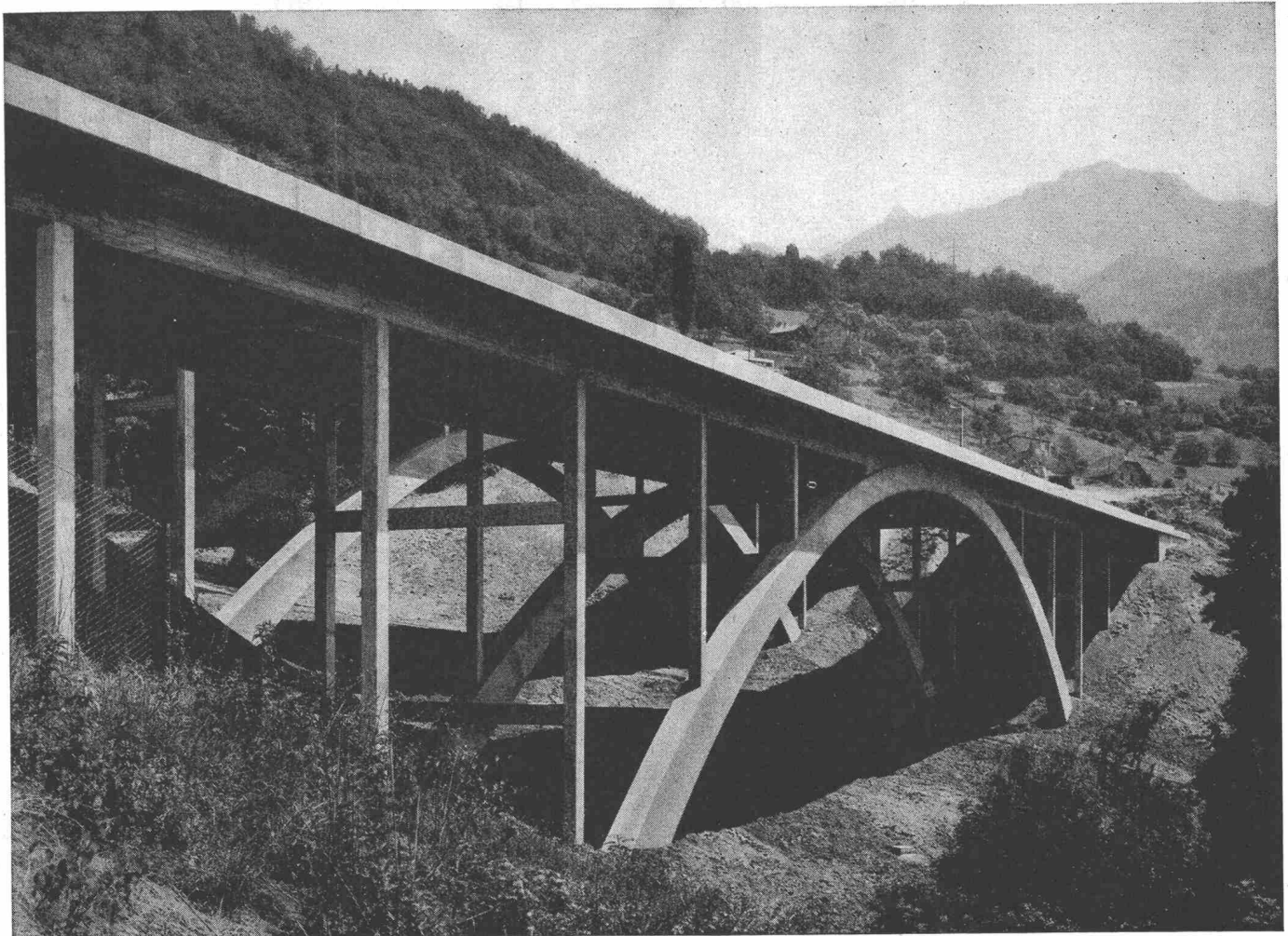
Autobahn N 9 Pont des Vuarennas, Chernex VD
