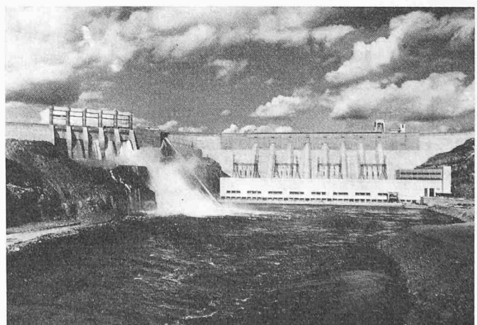
Bild 13. Das Kraftwerk Manicouagan 2. Leistung 8 \times 127 MW, Nutzgefälle 72 m, Jahresarbeit 5,7 TWh. Photo «Quebec-Hydro»
