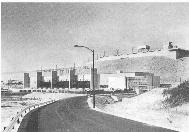
Bild 6. Das Kraftwerk Grand-Rapids auf dem Saskatchewan-Fluss. Leistung 3 \times 110 MW (im Endausbau 440 MW). Photo «Manitoba-Hydro»
