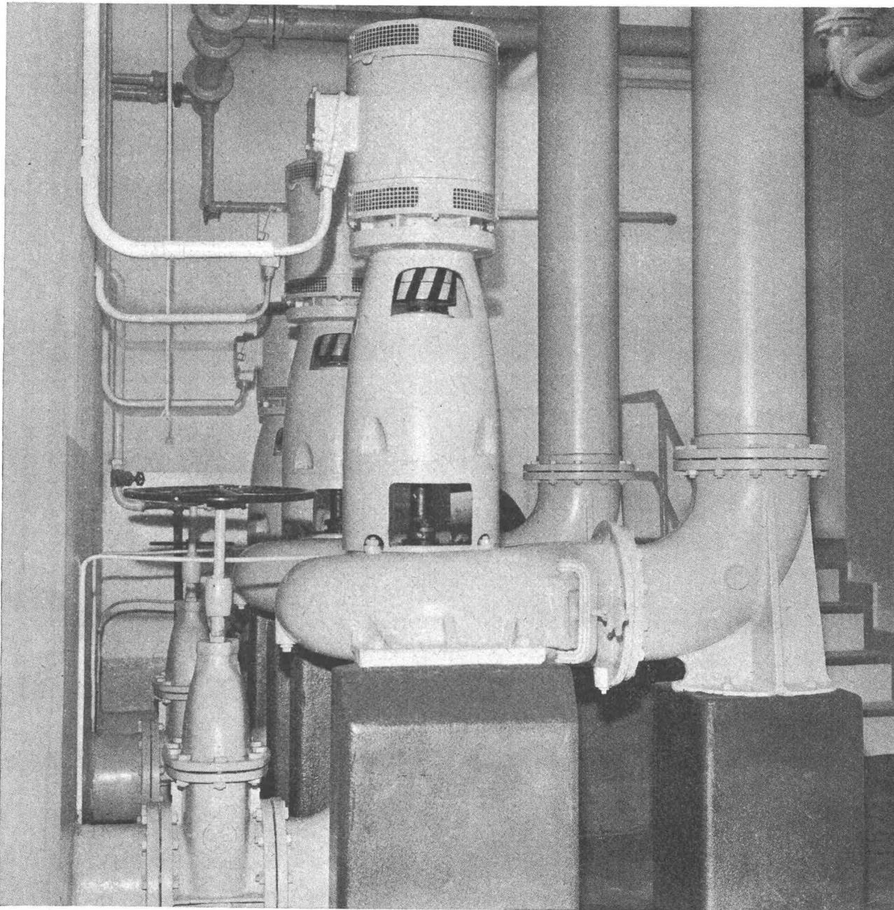
Abwasser-Pumpstation Nyon, 3 Schraubenradpumpen von 200 bis 300 mm I.W.
