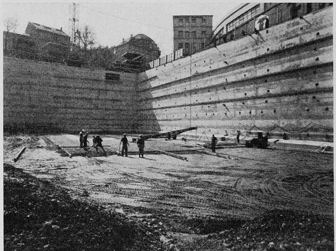
Bild 3. Nach der Unterfangungsmethode erstellte Baugrube der Parkgarage Elisabethenschanze in Basel. Die einzelnen Elemente sind mit Kiesankern zurückverankert
