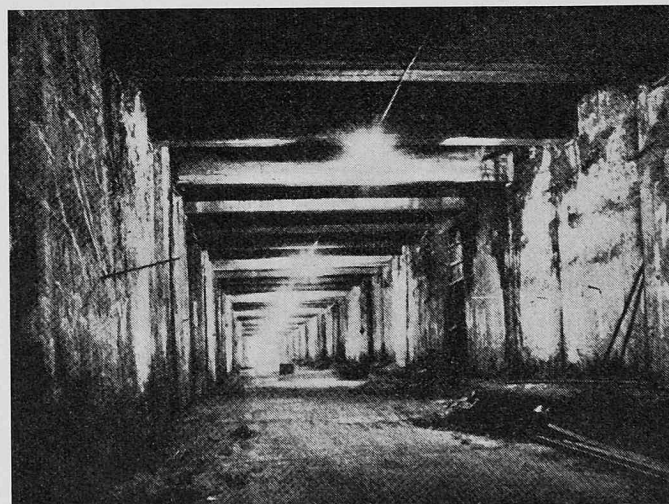
Bild 10: Tiefbahn Wien: Tunnel mit seitlichen Schlitzwänden
