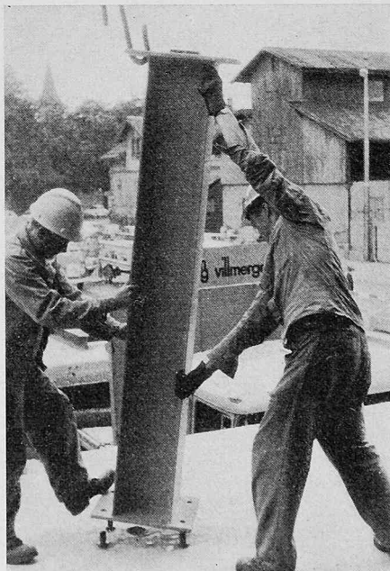
Bild 6. Absetzen der Stahlstützen auf genau horizontalisierte Stellmuttern
