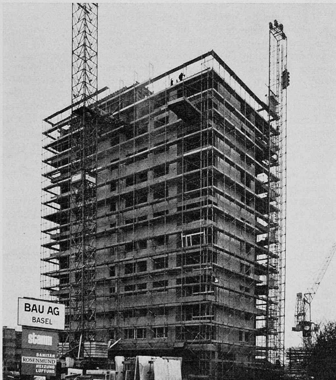
Baufaufnahme von der Friedhofstrasse gegen Hochhaus 1
