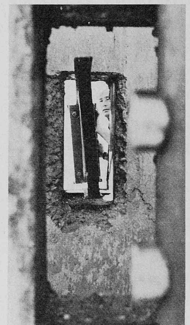
Bild 12. Einführen eines Durchschubträgers in die Aussparungsdoppelkasten
