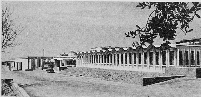
Bild 2. Hallenkonstruktion mit aneinandergereihten «U»-Faltwerken in Sesto Fiorentino / Italien. Ausführung CODELFA, Milano
