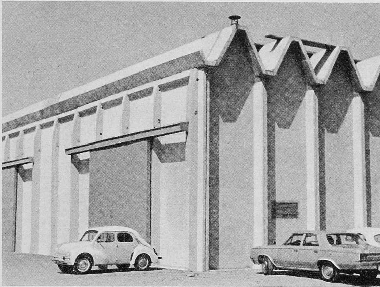
Bild 12. Shedhalle mit «Z»-Faltwerken und tragenden Aussenwänden in der Schweiz
