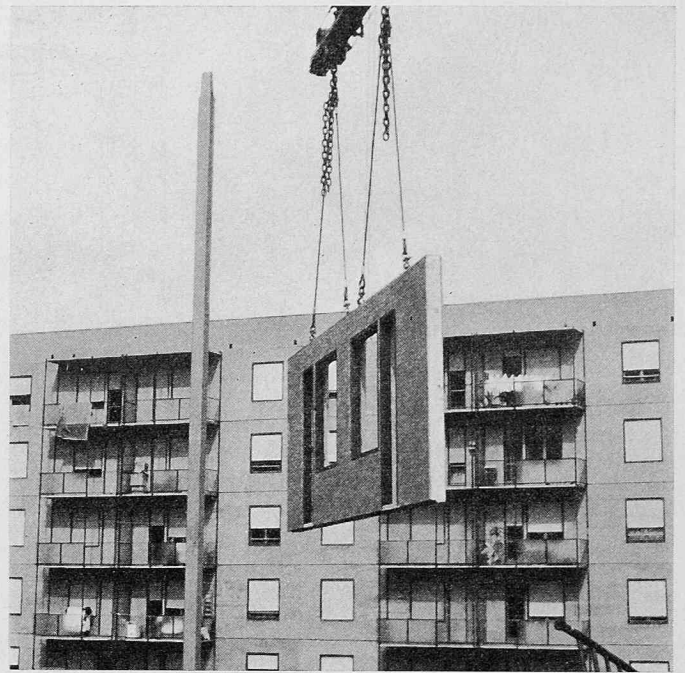
Bild 20. Versetzen einer Aussenwandtafel, welche eine ganze Wohnungsbreite hat. Im Hintergrund bereits bewohnte Häuser
