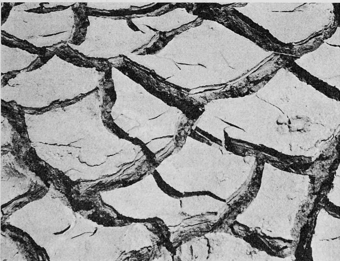
Bild 30. Polygonale Rissbildung an der Oberfläche einer Lehmschicht (vgl. Bild 29)
