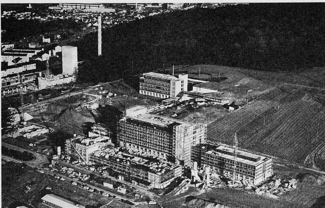
ETH-Aussenstation Hönggerberg Zürich , Areal für Physikbauten. Die Skizze (oben) vermittelt einen Ueberblick über die gesamten Physikanlagen, welche im NE-Quadranten der Aussenstation konzentriert sind. Die Erstellung (unten) der Energieversorgungsanlage, des Laboratoriums für Kernphysik und des Institutes für Technische Physik samt dessen Abteilung für Industrielle Forschung (AFIF) stellen die drei Vorläuferbauten der Physikinstiute dar und beruhen auf einer bundesrätlichen Botschaft vom 7. Februar 1961. Im Hintergrunde links Zürich-Affoltern
