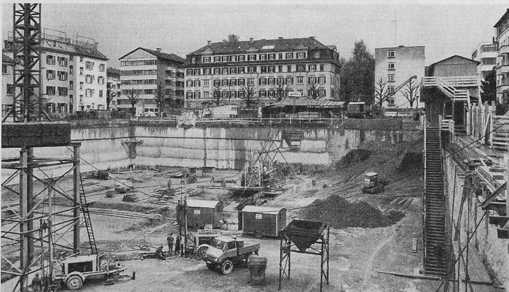
Bild 19b (nebenstehend): Baugrube «Alterssiedlung Dufourstrasse» in Zürich (Situation Bild 19a), Bohrgeräte beim Erstellen der Vertikalanker
