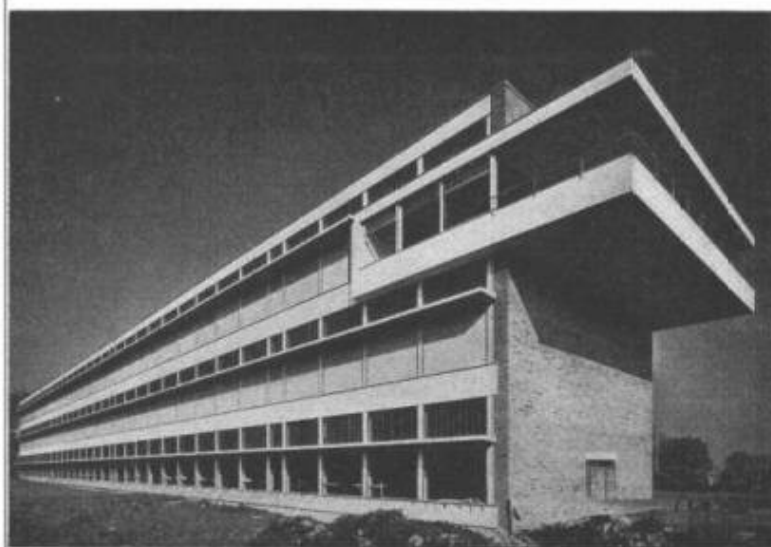
Neubau des Schützenhauses Zürich-Albisgölli
